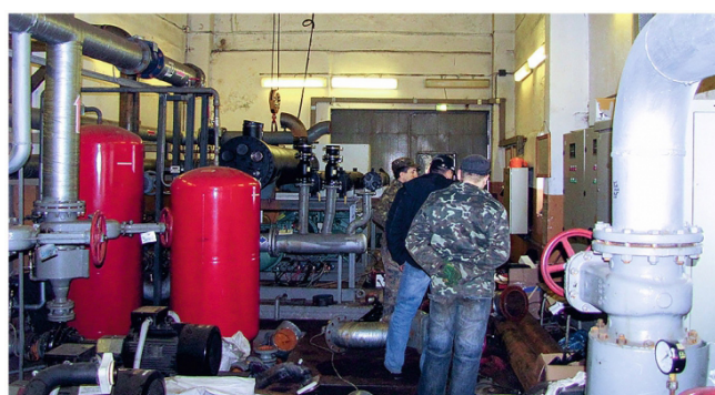
❖ Фото 4. Монтажные работы по реконструкции оборудования АТНУ
