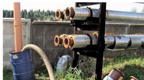
❖ Фото 8. Промывка теплообменника-утилизатора
