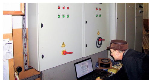
❖ Фото 9. Процесс наладки системы удалённого мониторинга
