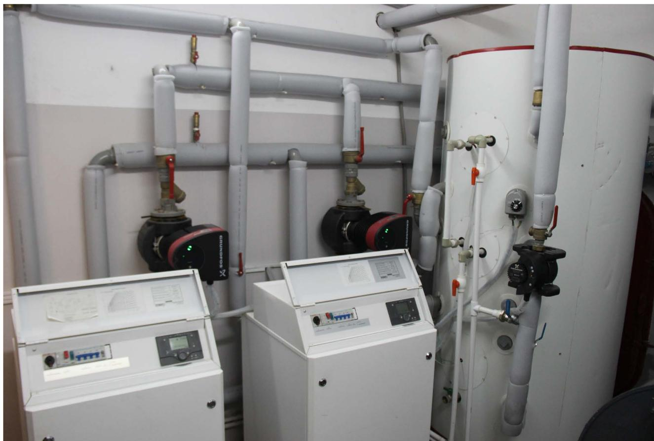
На сегодняшний день в ТОО «СГХК» установлено два тепловых насоса в одном здании. Для этого пробурены девять скважин, углублены трубопроводы, установлены геотермальные зонды, создан замкнутый контур. Система начала работу летом в режиме горячего водоснабжения, а 14 октября было запущено отопление.
