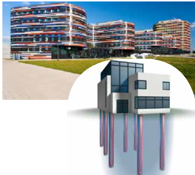
Рис. 8 Городское управление по развитию, экологии и защите окружающей среды г.Гамбург, тепловой насос DS 6500
