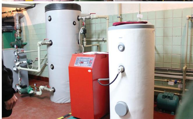
В 2013-2014 годах наша компания внедрила тепловой насос – утилизатор тепла, мощностью 150 кВт на заводе АО «Мотор Сич», Запорожье.
