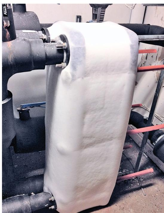
Теплообменник (предназначен для охлаждения льда в ледовом дворце Lofbergs Arena)
