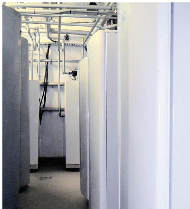
*Каскад тепловых насосов, установленный в ледовом дворце Löfbergs Arena*
