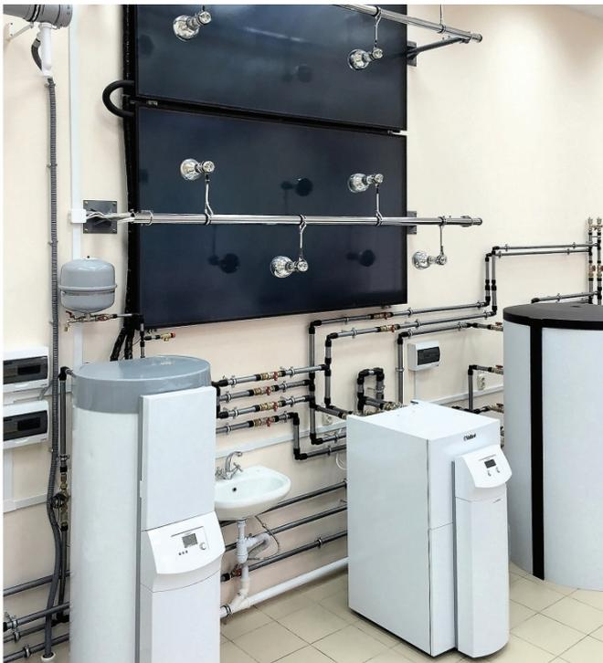
Фото 2. Гелиустановка, тепловой насос и аккумулятор тепла
