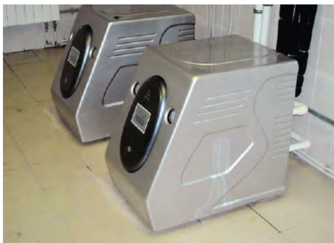
Помещение водоподготовки бассейна Самарского государственного университета
