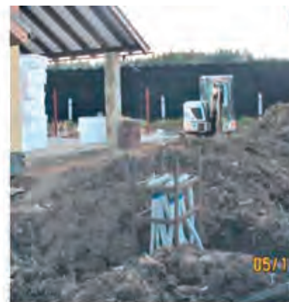
Зонды готовы: пробурены скважины, в каждую из них опущено по два витка труб, скважины заполнены цементно-песчаным раствором, а трубы (всего их 6, а значит, 12 выходов) подсоединены к распределителям рассола
