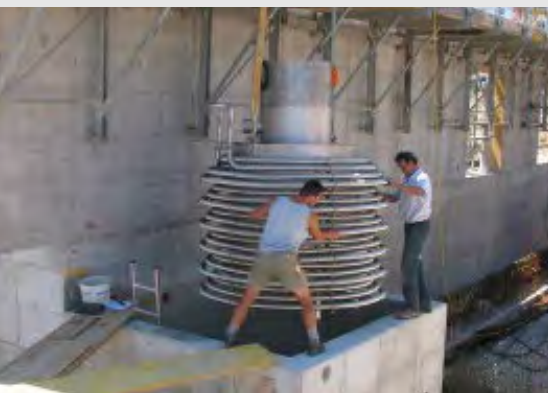
Фото 5. Монтаж теплообменника-утилизатора теплоты сточных вод в канализационном колодце
