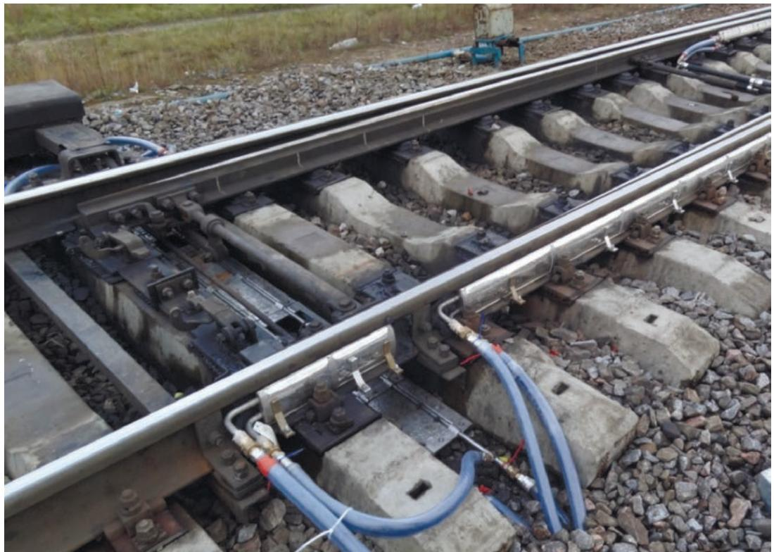
**Рис. 27. Система геотермического обогрева стрелочного перевода**
