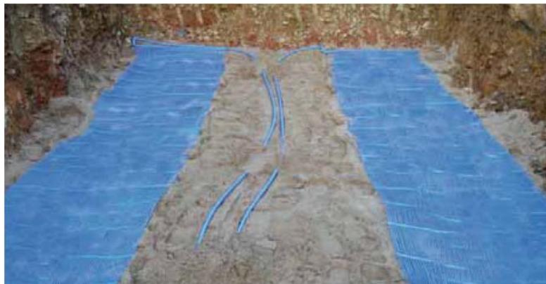
Укладка компактного коллектора
