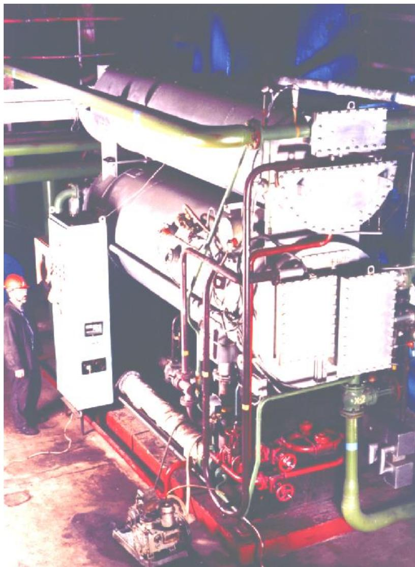
Рис. 3.2. Абсорбционный бромистолитиевый тепловой насос АБТН-2000 П
