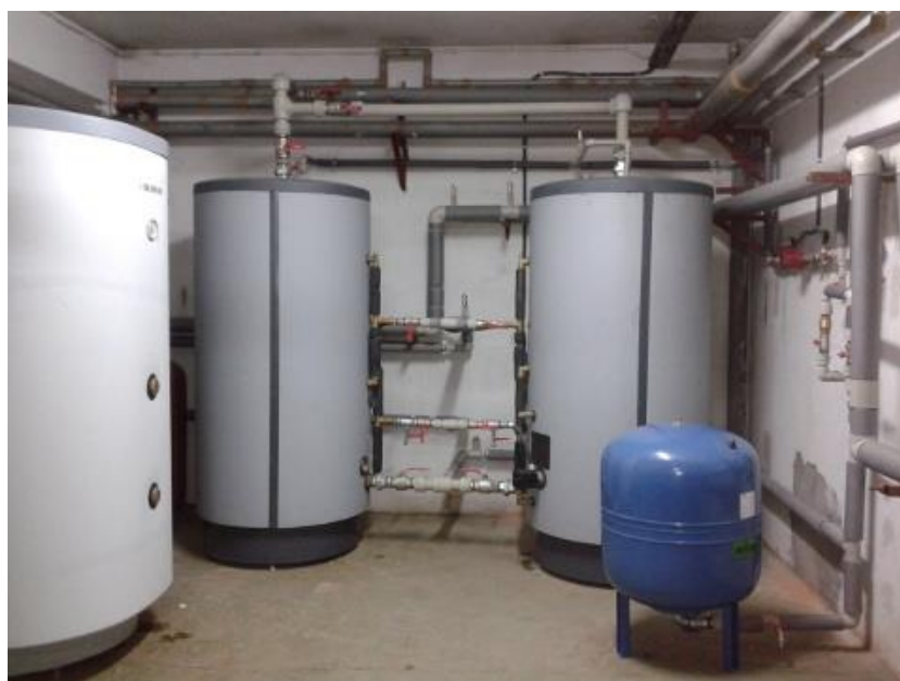
Илл. 4.8 – Размещение и обвязка аккумуляторов горячей воды
