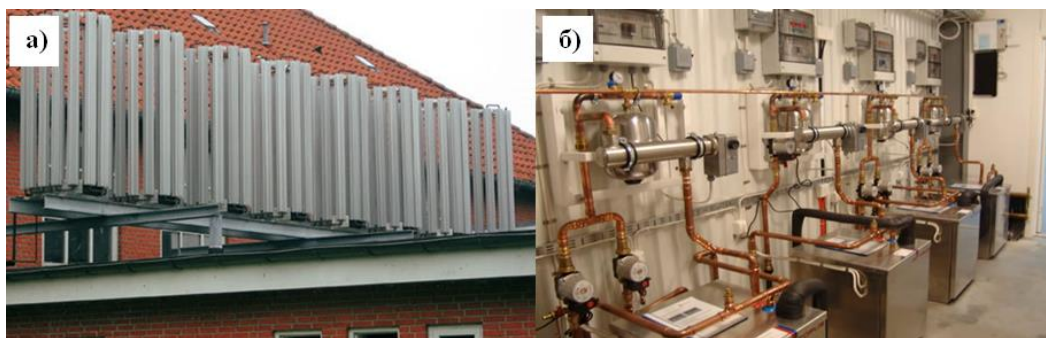
Илл.4.7 – Размещение каскада из испарителей (а) и компрессорно-конденсаторных блоков (б) тепловых насосов «воздух-вода» модели 120X фирмы «Octopus»
