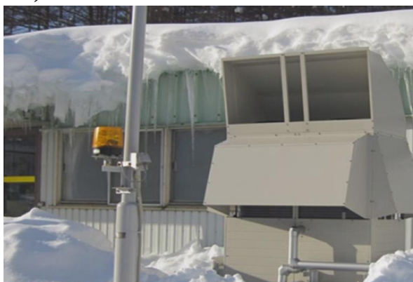
Илл. 4.5 – Вид на тепловой насос «воздух-вода» с элементами для защиты от воздействия снега и ветра
