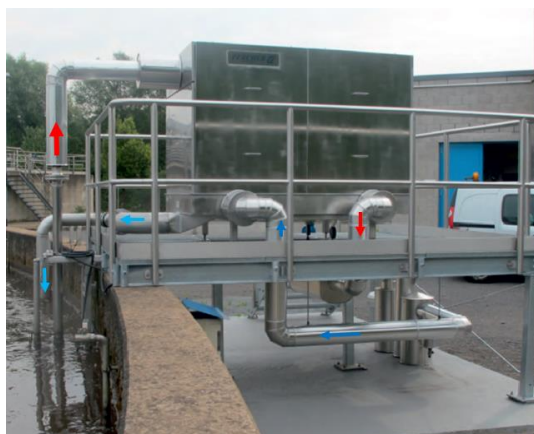
Илл. 2.8 – Пример размещения и обвязки теплообменников «сточные воды – теплоноситель контура испарителей» на сооружениях биологической очистки
