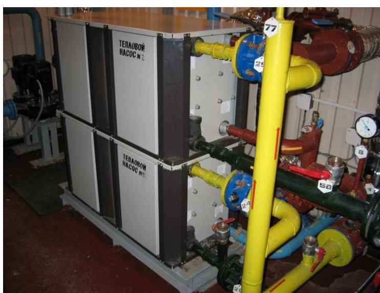
Илл.4.4 – Размещение и обвязка тепловых насосов GWC020BC фирмы «GEA» (Германия)
