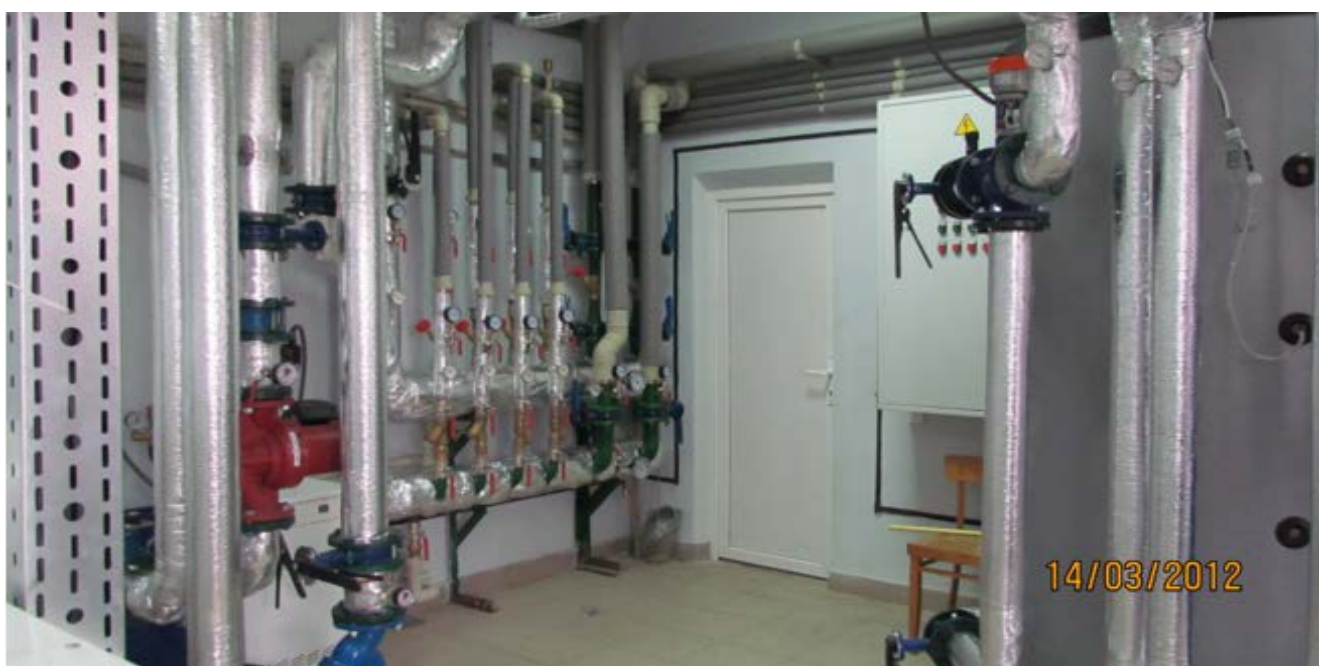
Установка теплового насоса на объектах «Укрзалізниці»
