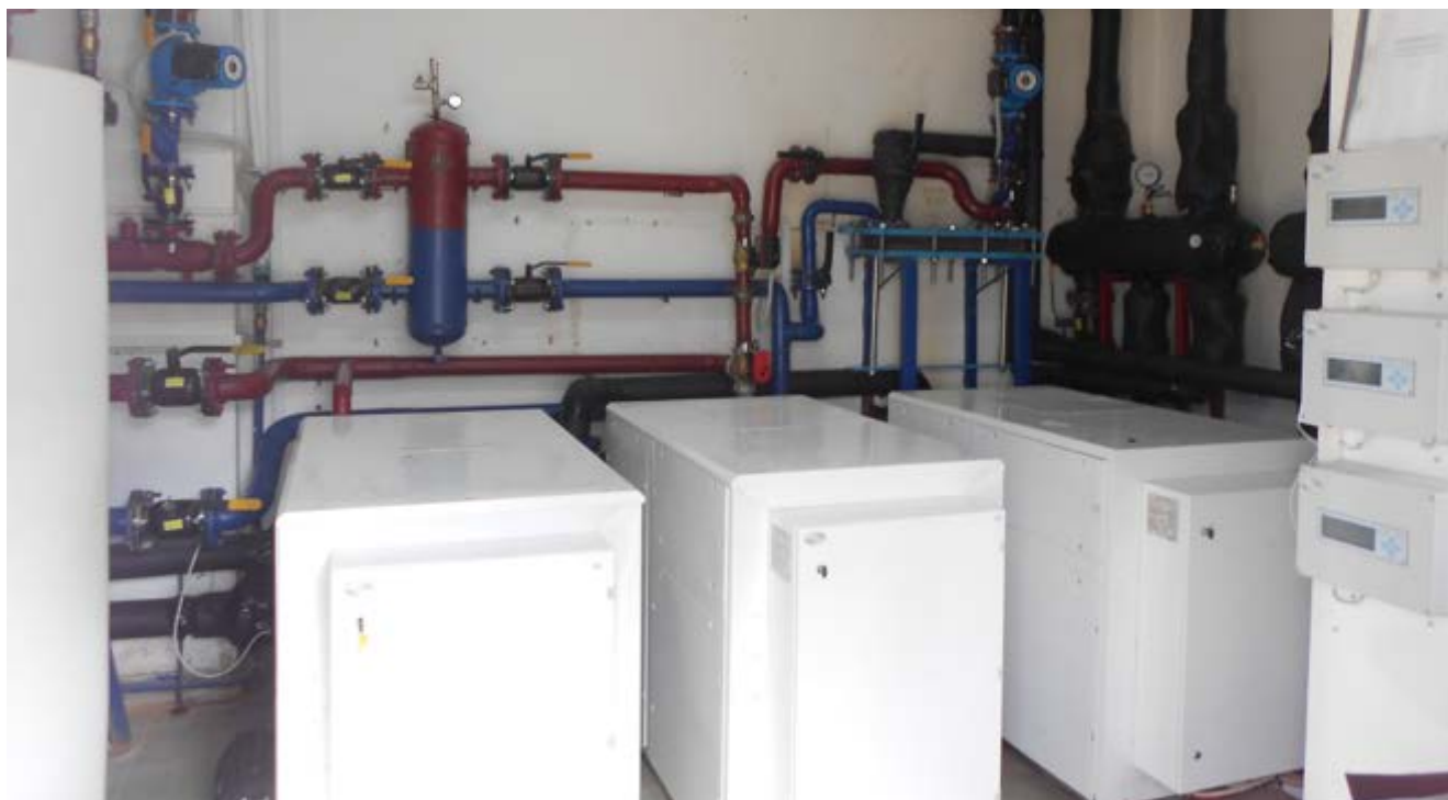
Тепловой насос в гостиничном комплексе «Панская Гора»
