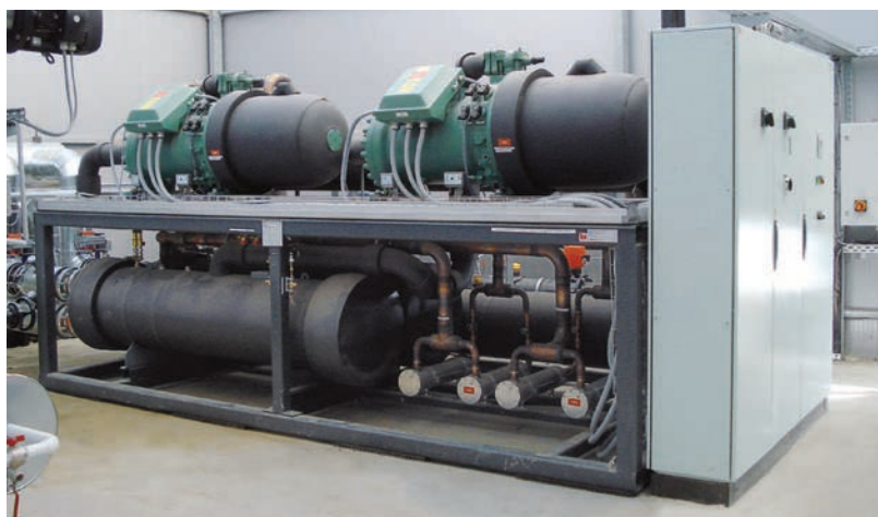
Водо-водяной тепловой насос мощностью 1560 кВт
