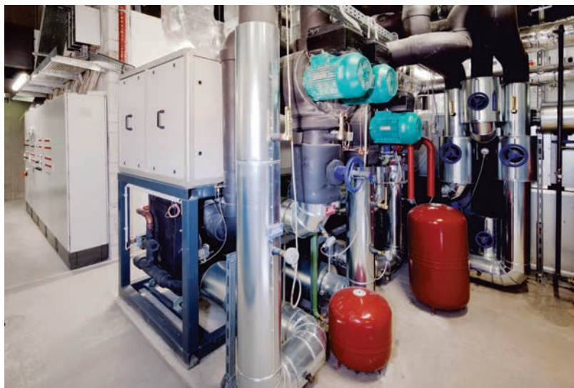
Рассольно-водяной тепловой насос мощностью 286 кВт
