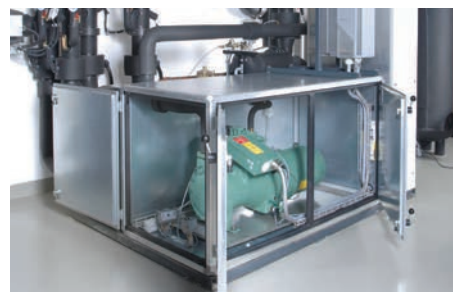
Взгляд на установку изнутри: эффективный компрессор в шумо-и виброизоляционном корпусе.
