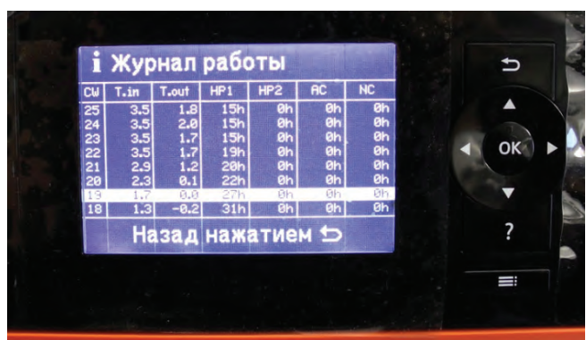
Конец отопительного сезона (CW - номер недели; T.in - температура теплоносителя грунтового контура на входе в тепловой насос; T.out - температура теплоносителя грунтового контура на выходе из теплового насоса; HP1 - количество часов наработки компрессора)
