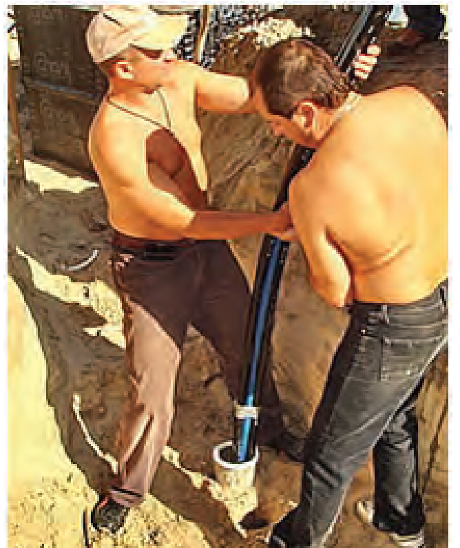
Двойной (увеличенная мощность теплосъема) U-образный грунтовой зонд с наконечником. Заводское изготовление, 16 атм.
