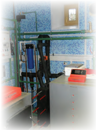
Тепловой насос вода/вода мощностью 30 кВт с функцией «естественного охлаждения»
