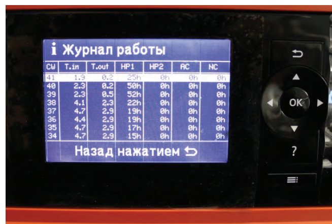
Начало отопительного сезона (CW - номер недели; T.in - температура теплоносителя грунтового контура на входе в тепловой насос; T.out - температура теплоносителя грунтового контура на выходе из теплового насоса; HP1 - количество часов наработки компрессора)
