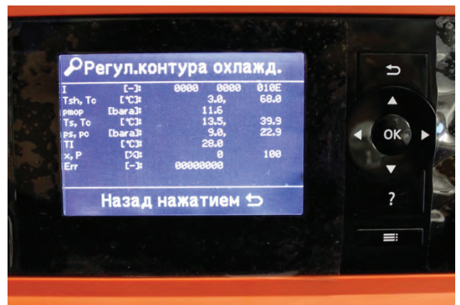
Параметры рабочего контура теплового насоса
