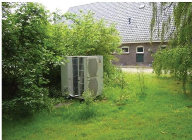
На фотографии внизу показана наружная часть теплового насоса воздух-вода установленного в существующем здании (в данном случае ферма была переделана в жилой дом).
