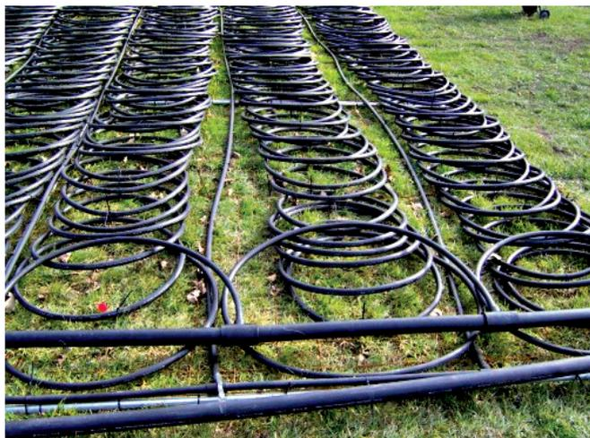
Элемент конструкции горизонтального теплонасоса источником тепла для которого может быть почва, подземные воды, водоём. Такие теплонасосы называют также геотермальными.
