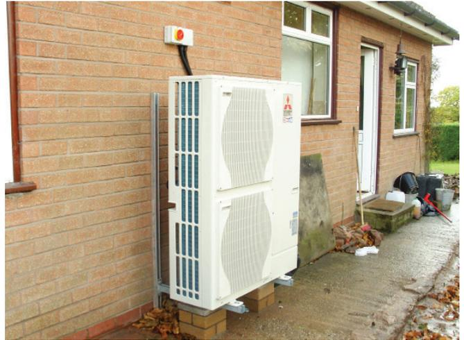
Энергетическая эффективность преобразования энергии в тепловом насосе оценивается коэффициентом преобразования энергии (COP), равным отношению энергии, переданной потребителю, к энергии, затраченной для реализации цикла:
