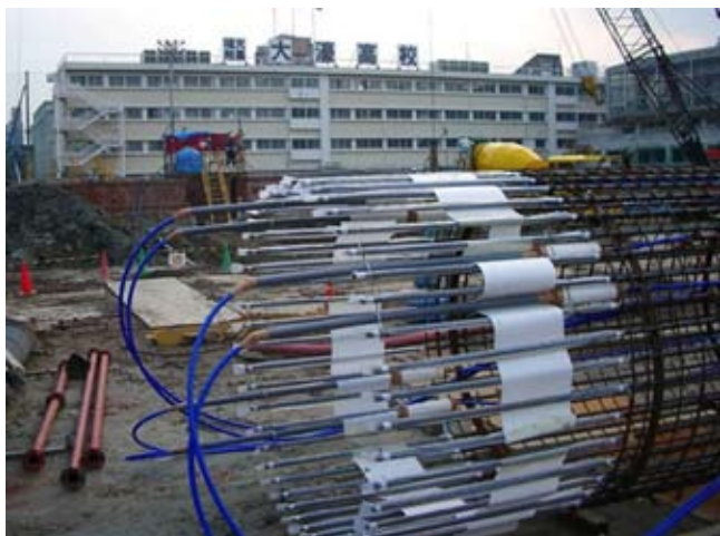
Фото 1. Энергетические сваи, отливаемые из бетона. Слева: Четыре U-образных трубы, закрепленные на усиленный каркас. Справа: Установка четырех U-образных труб для бетонных свай
