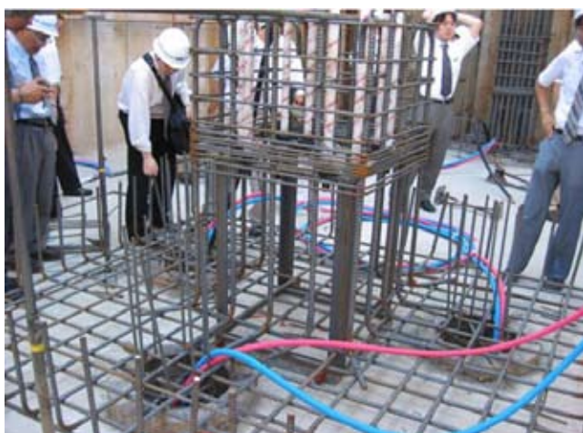
Фото 2. Прокладка трубы с открытой системой с использованием сборной железобетонной сваи и крышка сваи в здании образовательного центра города Fukui. Справа: две трубы проходят через усиленный каркас к основанию. Слева: Крышка сваи
