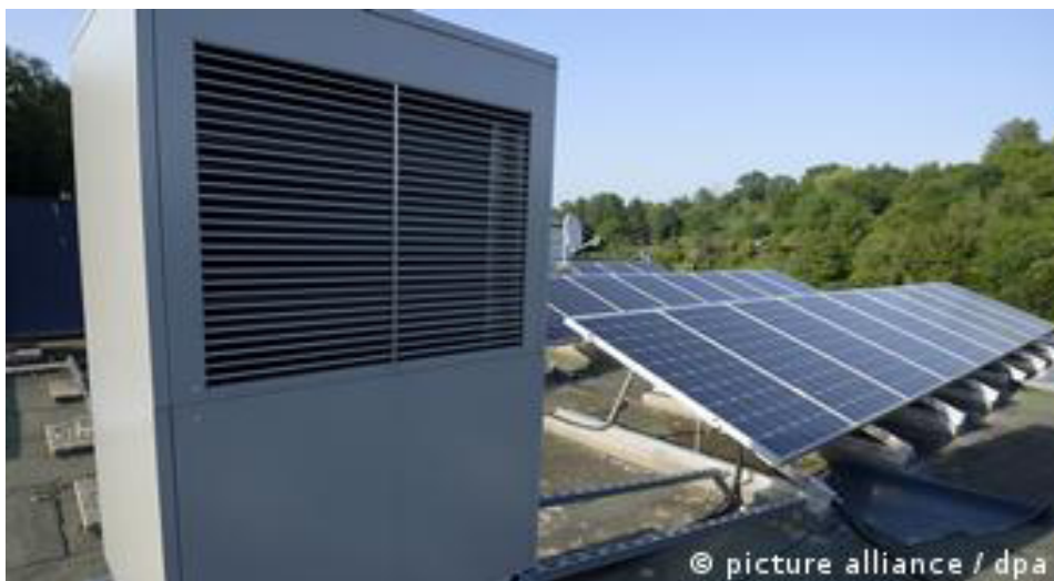
Тепловой насос и солнечные батареи на крыше жилого дома в городе Гёппингене
