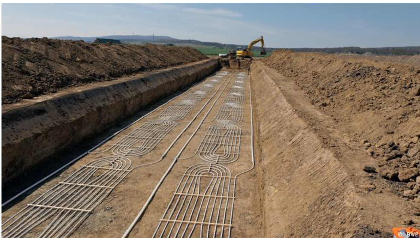
Строительство геотермальной системы отопления жилья в Наухайме
