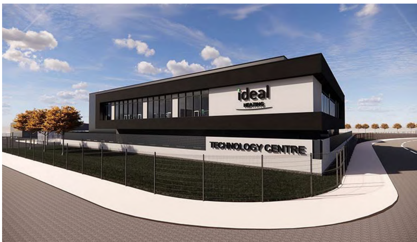
Новый центр исследований и разработок Ideal Heating по тепловым насосам Изображение: Ideal Heating
