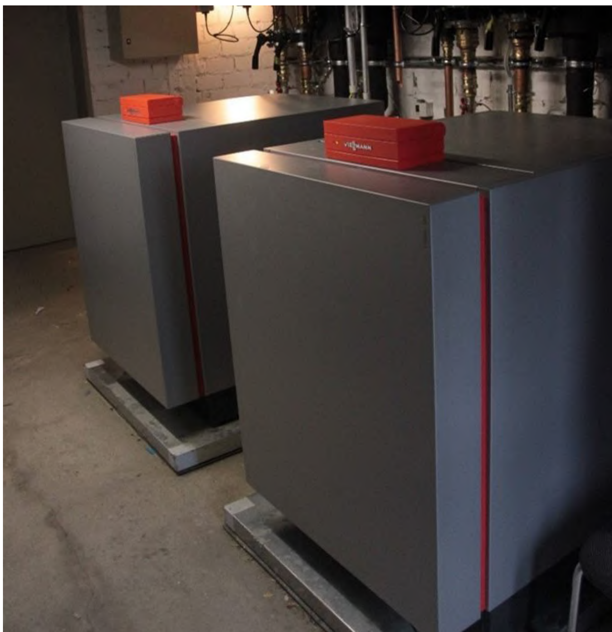
Тепловой насос с воздушным и наземным источником тепла от Fraunhofer ISE и Viessmann Изображение: Fraunhofer ISE
