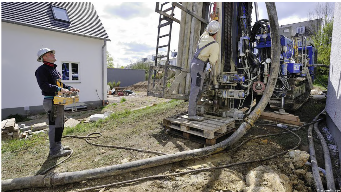
Бурение скважины для установки геотермального теплового насоса для индивидуального дома в Регенсбурге
